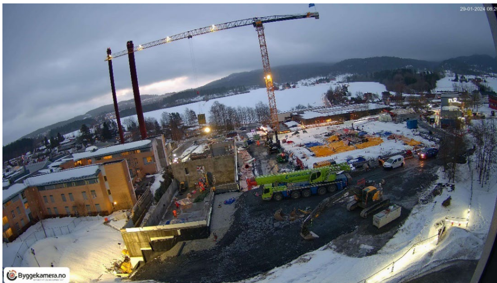
Bilde 6: Byggeplassen for samling av sykehusbasert psykisk helsevern, Akershus universitetssykehus, 29. januar 2024
