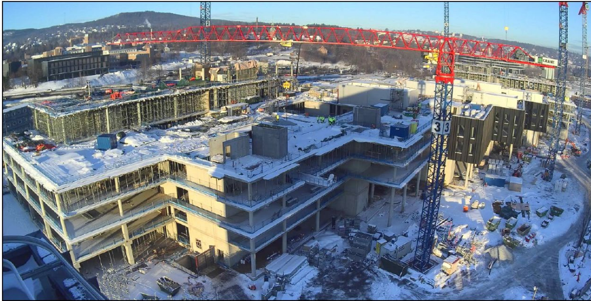
Bilde 3: Byggeplassen for Livsvitenskapsbygget, 9. januar 2024
