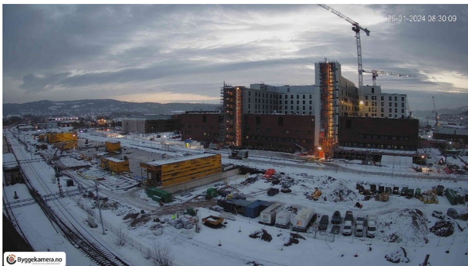
Bilde 1: Byggeplassen for nytt sykehus i Drammen, januar 2024
