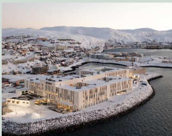
Nye Hammerfest sykehus.
