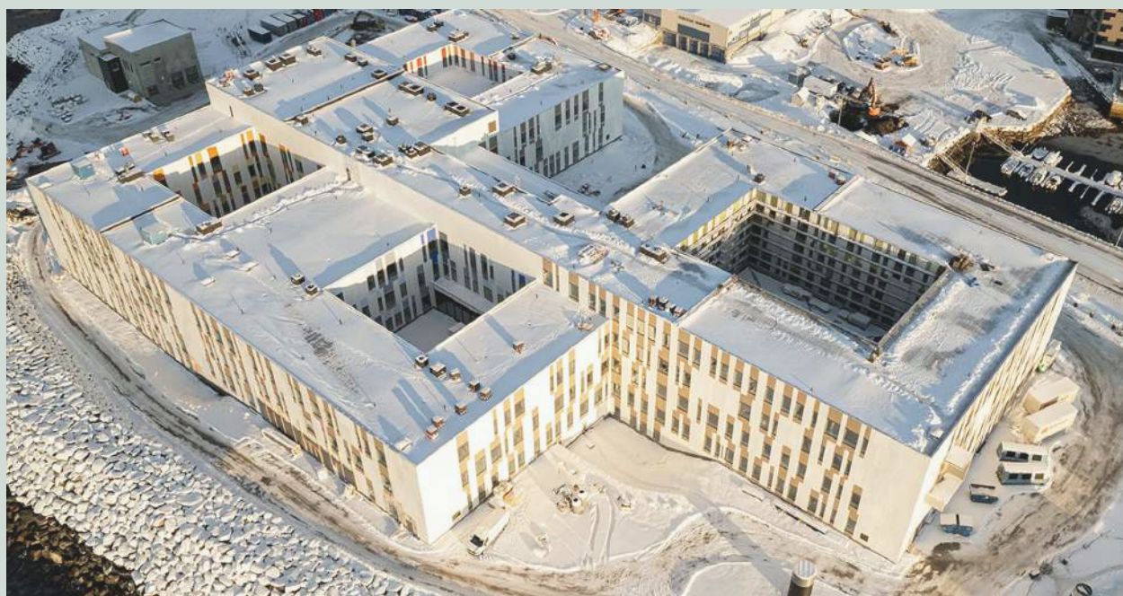
Nye Hammerfest sykehus.
