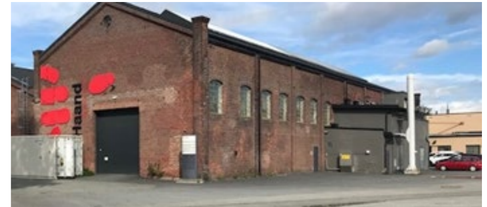
Bygg A Maskinhallen, Haandbryggeriet
