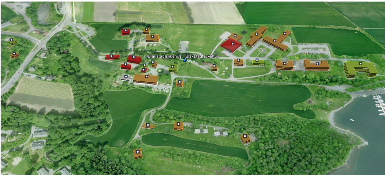
Figur 8. Blakstad sykehus, teknisk tilstand
