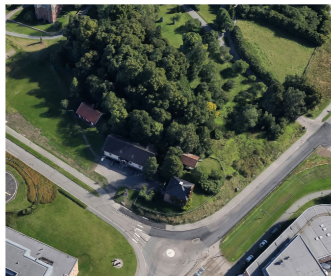
Bebyggelsen på Lindekollen skal bevares og integreres som en del av det nye atkomsttorget. Illustrasjon: Google Maps
