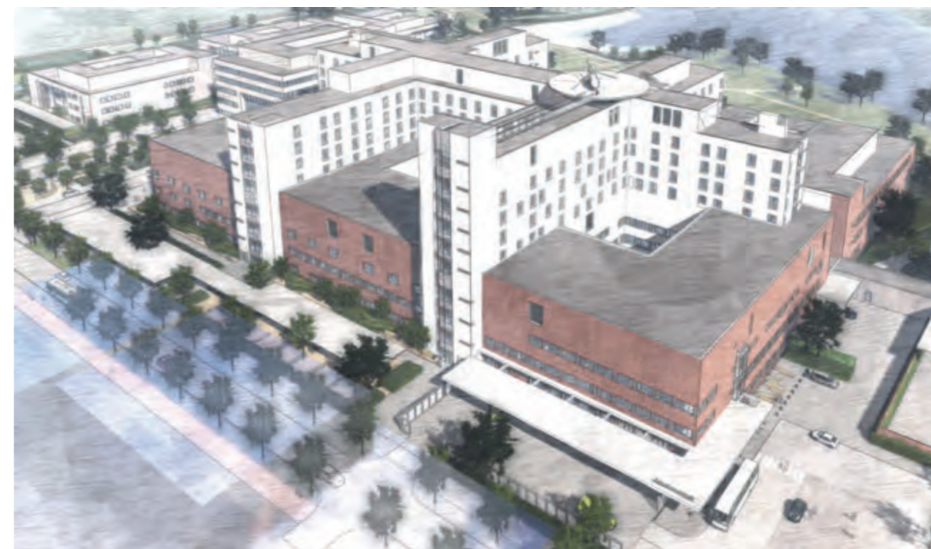
Fig. 02.1.14 Behandlingsbygg og sengebygg sett fra Helsegata
